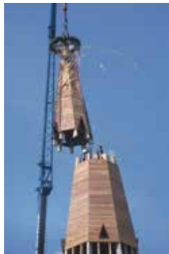
Mit einem Kran werden die beiden Teile des Dachstuhls auf den Turmschaft gesetzt
