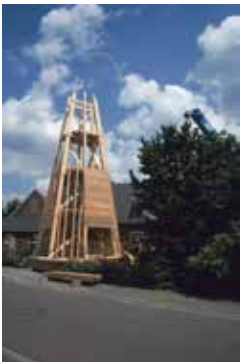
Auf dem Parkplatz wird der Dachstuhl gefertigt
